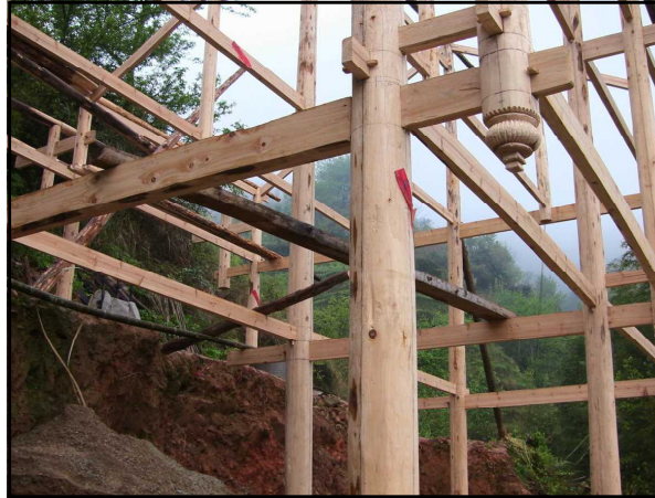
§ 建築中の民家の木組み
