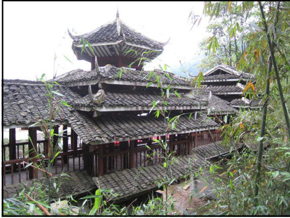
§ トン族の公共的な木造建造物 風雨橋
